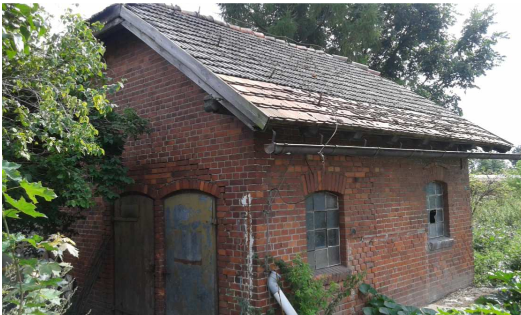
Fot. Widok na ścianę od strony północno-zachodniej. Urwana rura spustowa, naderwana rynna
