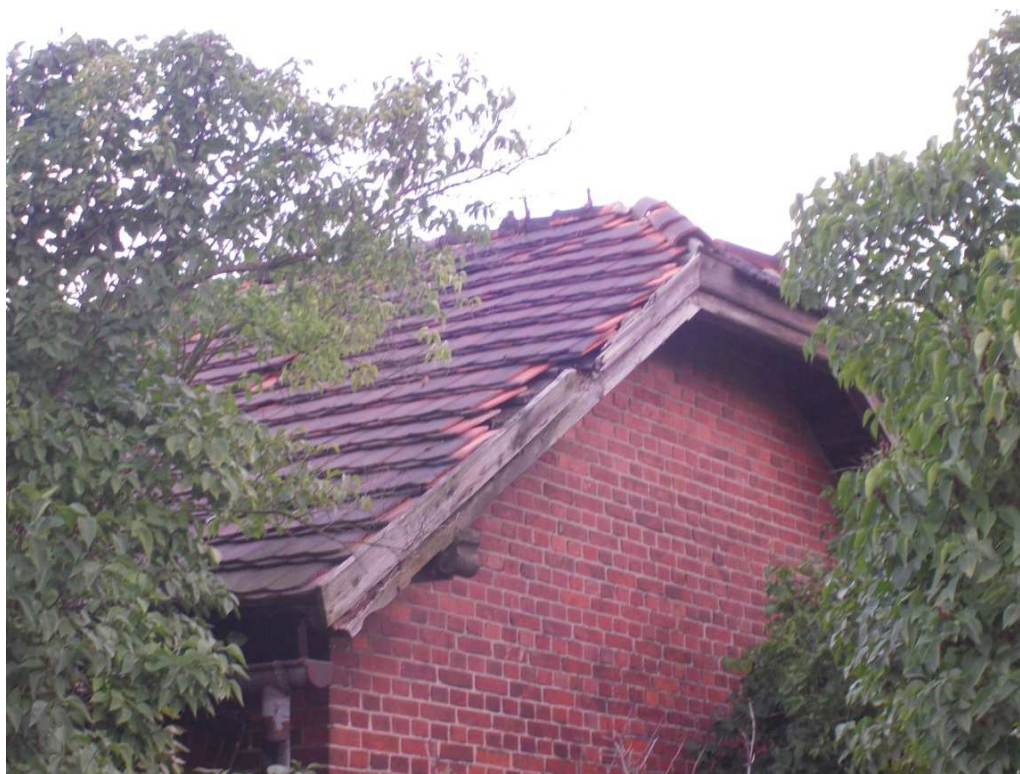
Fot. Miejskowe ubytki dachówki
