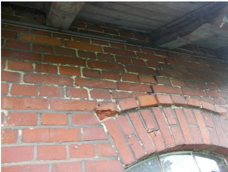
Fot. Pęknięcie ściany nad nadprożem okiennym oraz odłupany fragment cegły w murze
