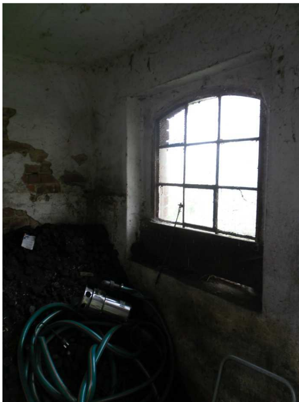
Fot. Zawilgocona ściana zewnętrzna
